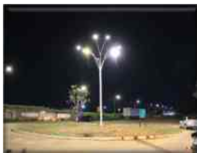
Iluminação na rotatória da Av. Rio Madeira
