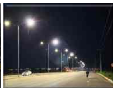
Reestabelecimento da iluminação pública na Av. Santos Dumont
