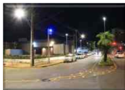
Instalação de postes ornamentos nas proximidades do Porto Velho Shopping
