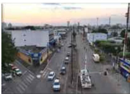
Manutenção no canteiro central da Av. Nações Unidas
